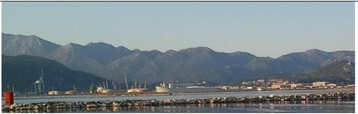
Pogled na luku Ploče (DT)
