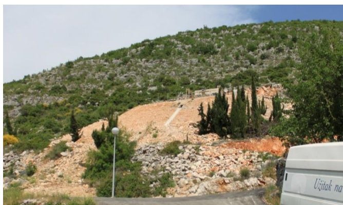
Nasipavanje u sklopu infrastrukturnih radova na rubu sela Gromače
