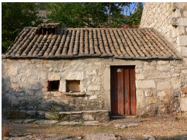
Prostorija s ognjištem i podignuti dio krova za odvod dima
