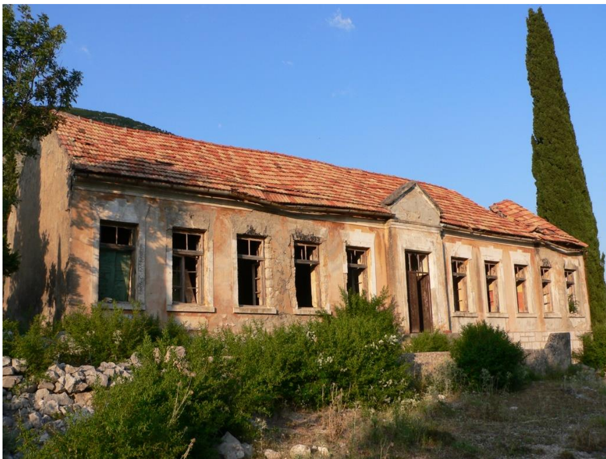
Zgrada stare škole
