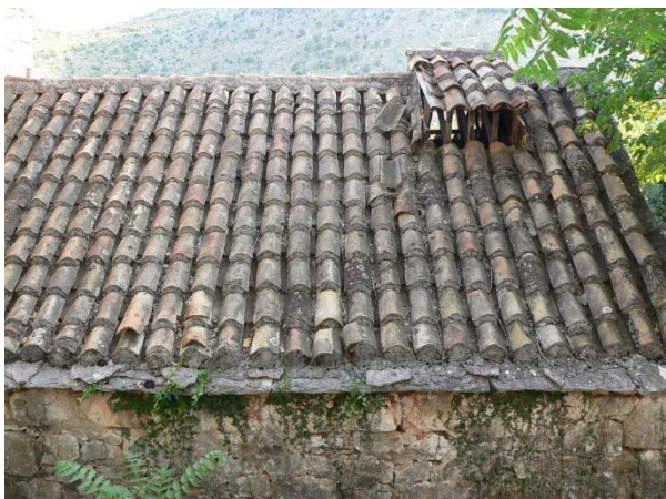
Krovni pokrovi: gore crijep, dolje kupa kanalice i kamene ploče (na kapeli sv. Liberana)
