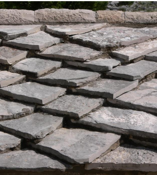
Krovni pokrov – kamene ploče
