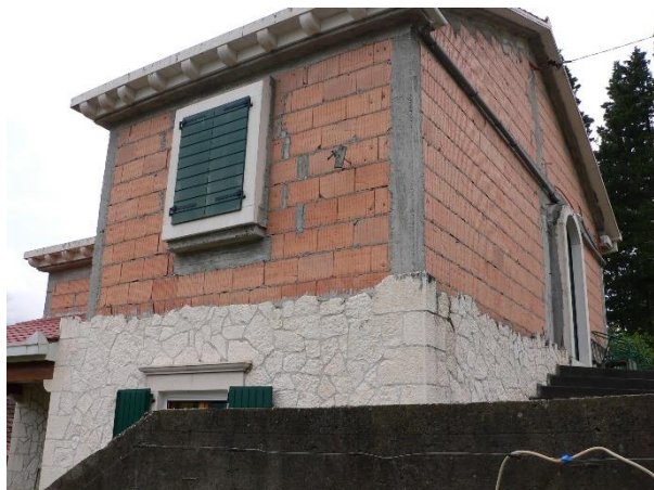
Primjeri pogrešnog oblaganja pročelja tankim kamenim pločama
