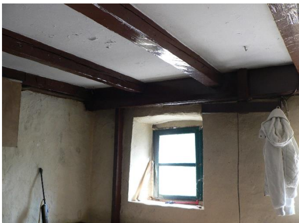
Drvena međukatna konstrukcija u Vidonjama (Zažablje)
