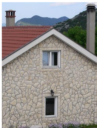
Primjeri „lažnih“ kamenih okvira
