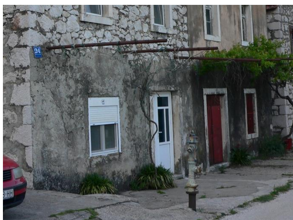
PVC i aluminijska stolarija na tradicijskim građevinama
