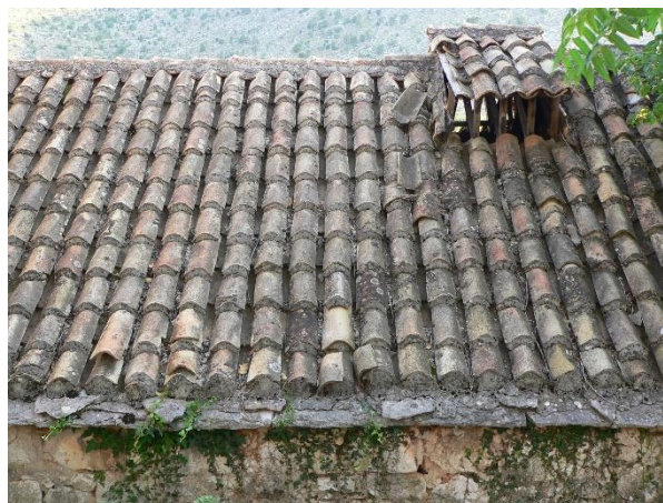
Krovni pokrov: kupa kanalice
