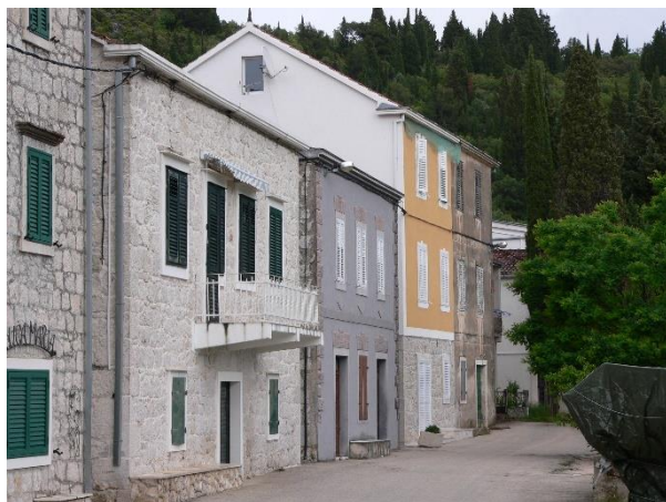
Ožbukana i kamena pročelja u Blacama (Slivno)
