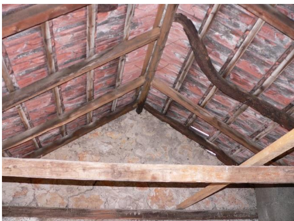
Krovna konstrukcija u Vidonjama (Zažablje)
