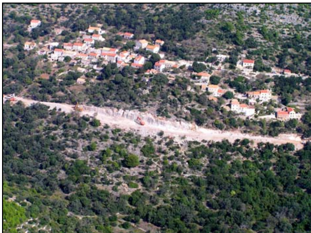
Babino Polje. Središnje naselje Općine Mljet. Smješteno je na prisojnim padinama brda Grad. U prvom planu je izgradnja zaobilaznice, koja je danas već izgrađena.
