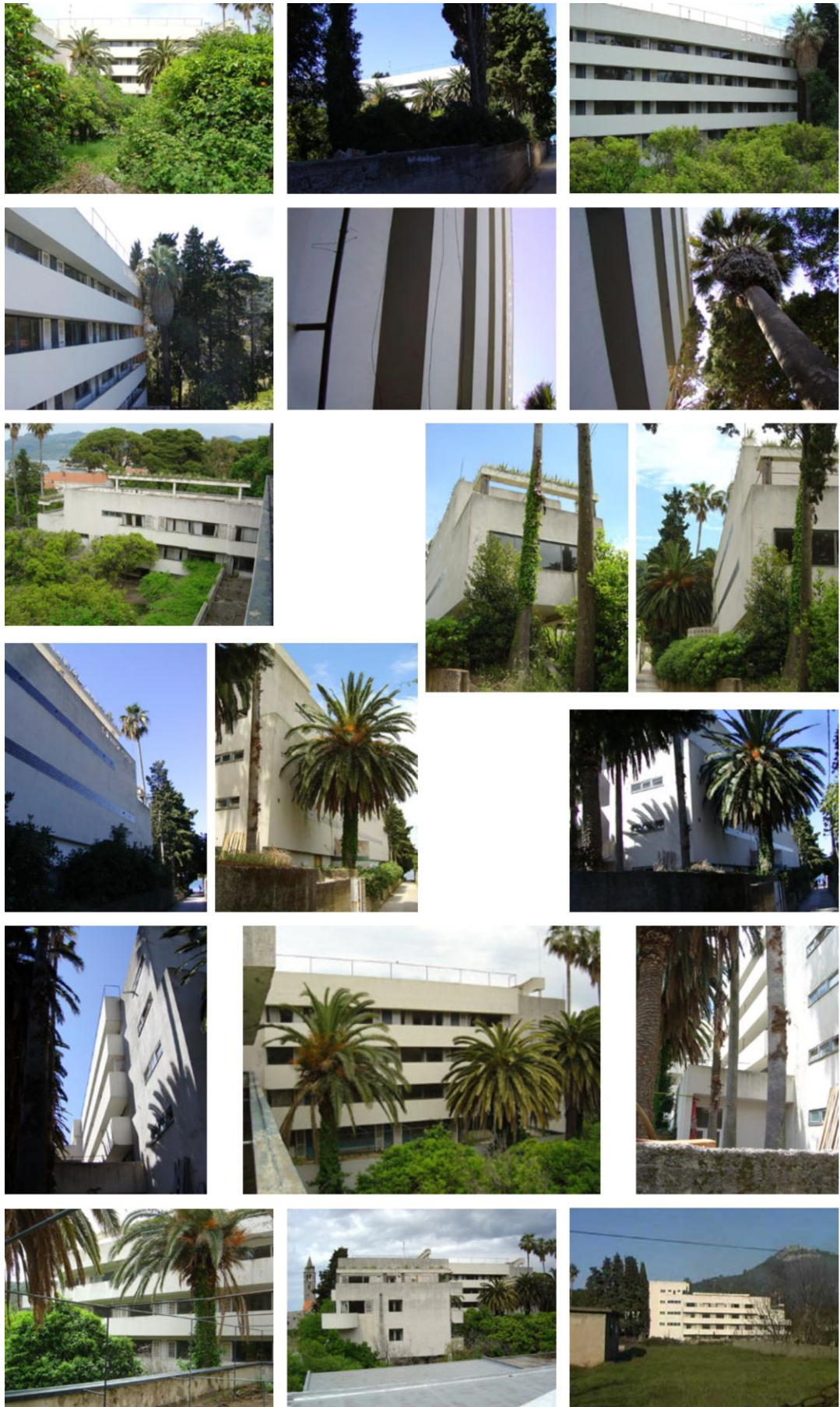
Postojeće stanje objekta – fasade centralnog objekta, sjeverozapadnog i jugoistočnog krila
