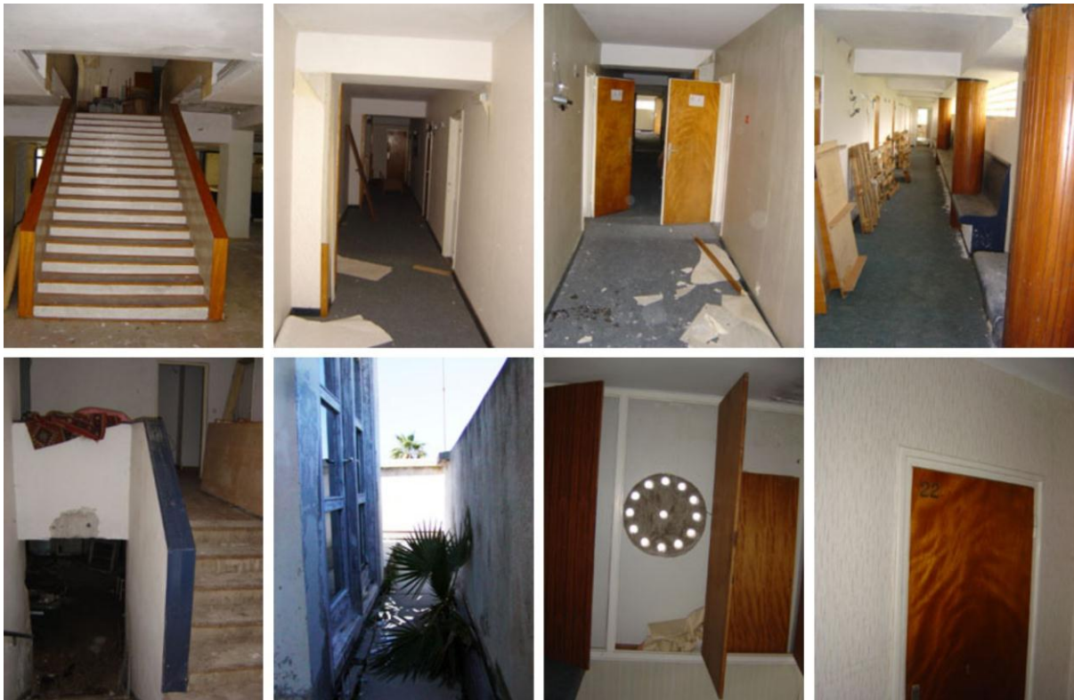
Horizontalne komunikacije – hodnici u glavnom traktu, u sjeverozapadnom traktu, prema podrumu, na terasi, na stubištu
