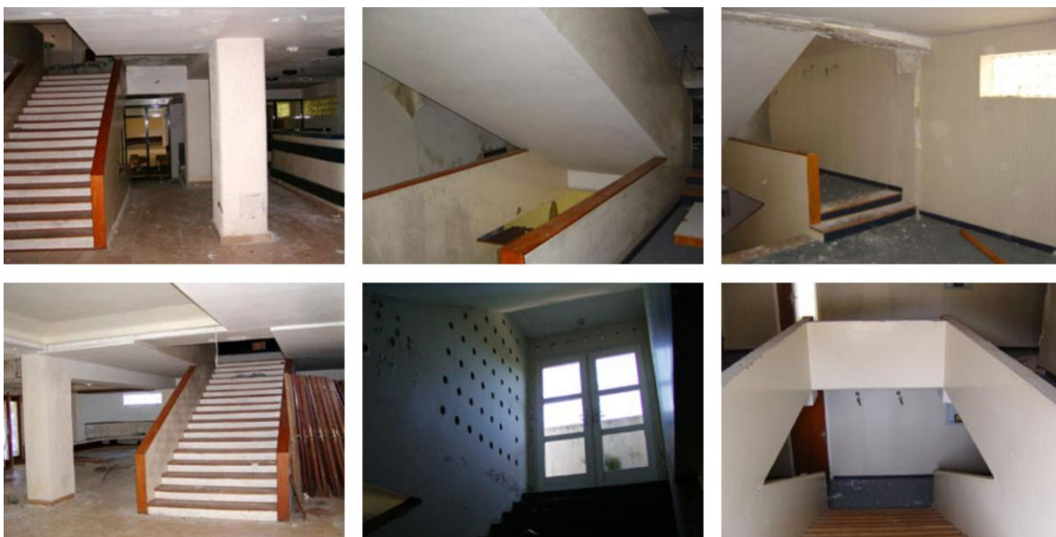
Vertikalne komunikacije u objektu, jednokraka stubišta s recepcije na kat, među katovima, u restoranu, na krovnoj terasi itd
