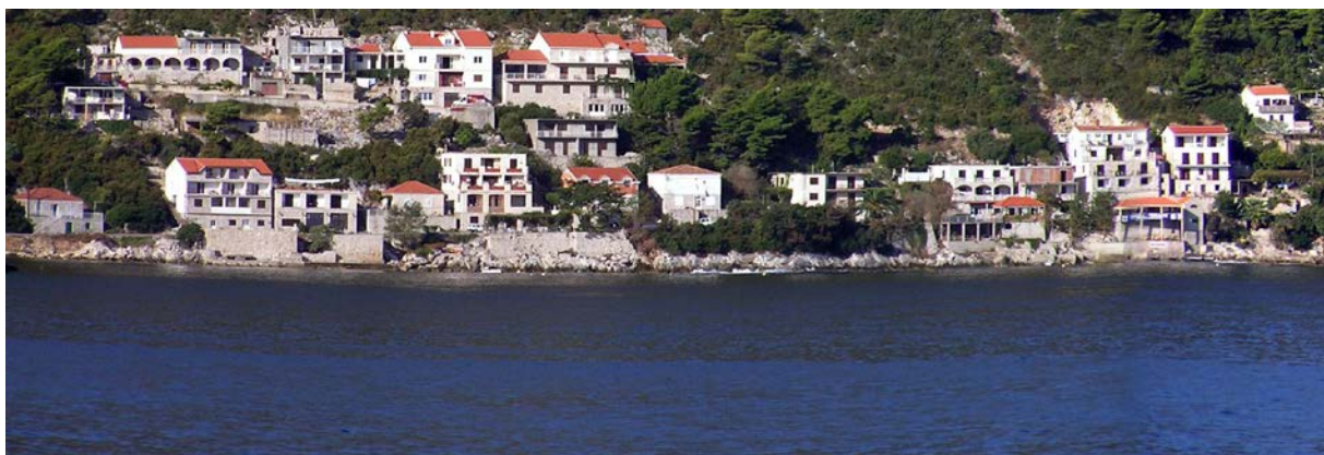
Slika 3-4: Improvizirane gradnje na samom pomorskom dobru, koje je potrebno sanirati uređenjem cijelog poteza između „uređene obale“ označene u Planu kao UO i obalne crte.
