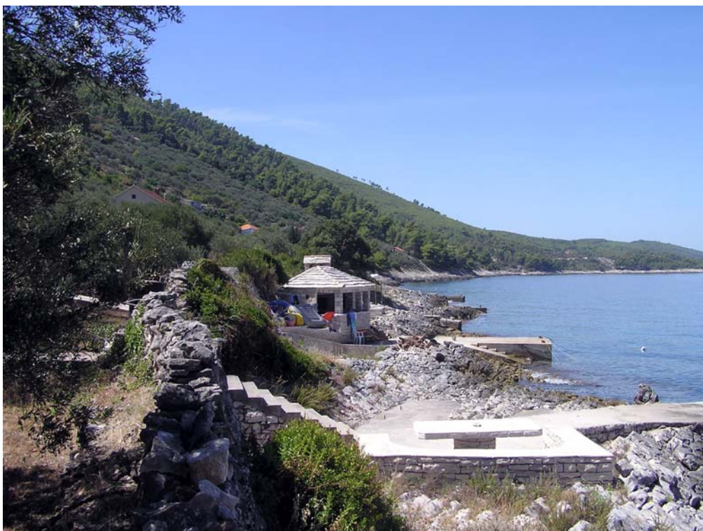
Slika 3-5: Obalno pročelje. Nužna je sanacija i oblikovno međusobno usklađivanje izgradnje. Nužna je izgradnja podziđa za prolaz ceste.
