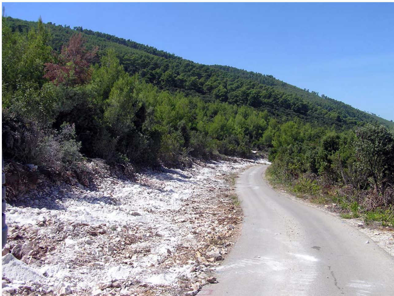
Slika 1-5: Nerazvrstana cesta L-69019, koja prolazi prostorom obuhvata Plana i završava u uvali Babina. Duž lijeve strane asfaltnog kolovoza polaže se cijev regionalnog vodovoda prema općini Blato.
