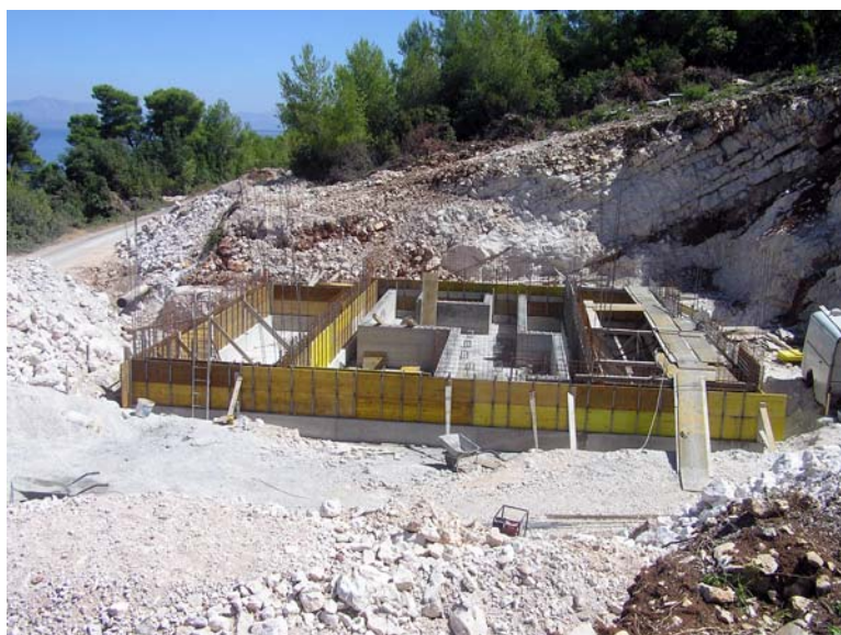
Slika 3-4: Izgradnja crpne stanice na potezu vodovoda NPKL(M) iz kojg će se vodoopskrbnog sustava opskrbljivati i područje Blaca. U okviru crpne stanice bit će i izvorna trafostanica za opskrbu električnom energijom područja Blaca.
