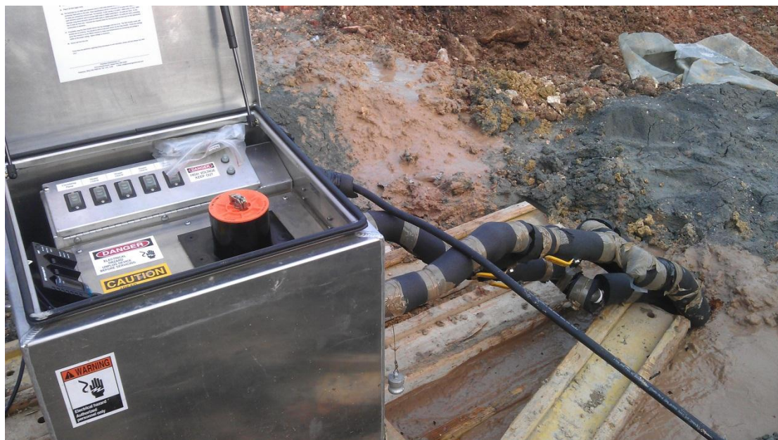
Slika 227. Izvođenje testa toplinskog odaziva (TRT) tijekom radova na instalaciji bušotinskog polja na lokaciji Stara Novalja, Studeni 2012.
