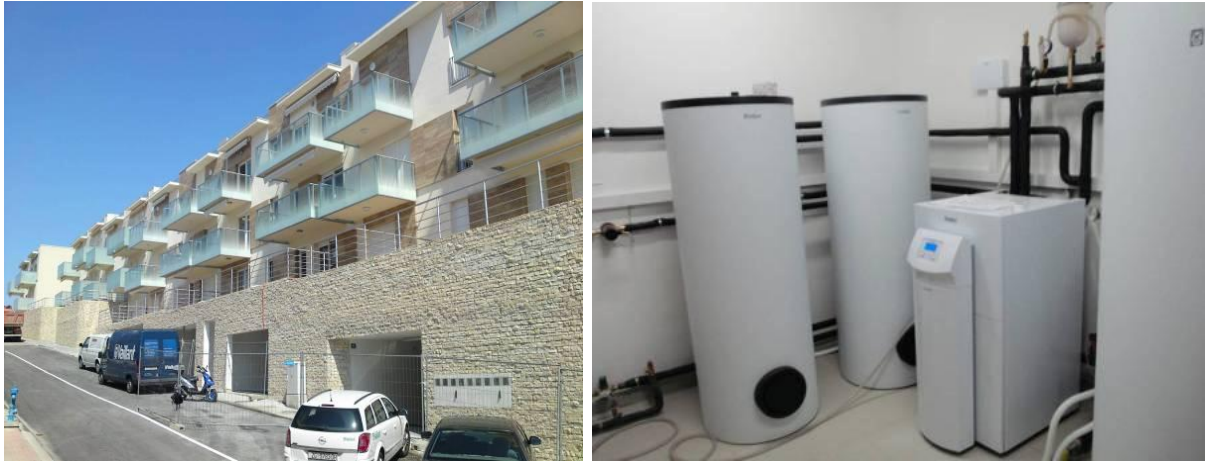
Slika 222. Višestambeni objekt Pazdigradska ulica, Split i unutrašnjost strojarnice
