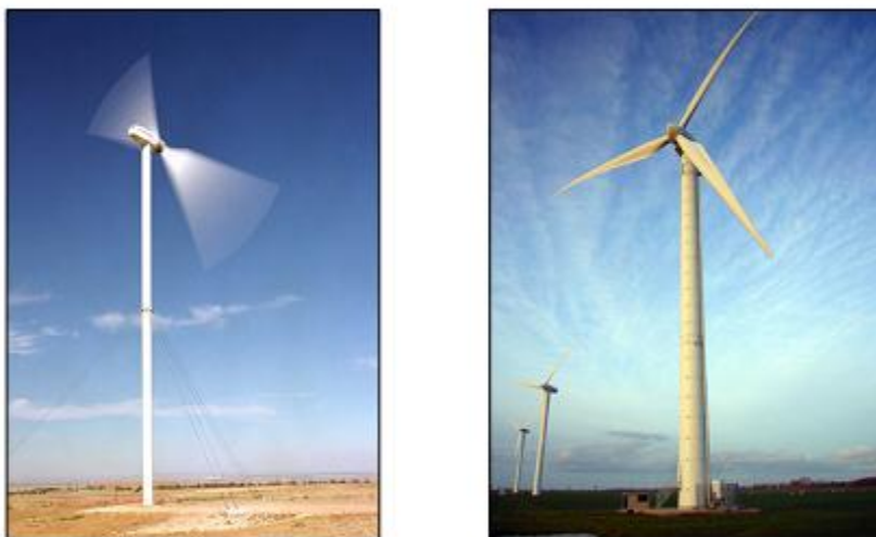
Slika 13. Izvedba VSHO sa stupom ispred lopatica i izvedba sa stupom iza lopatica
