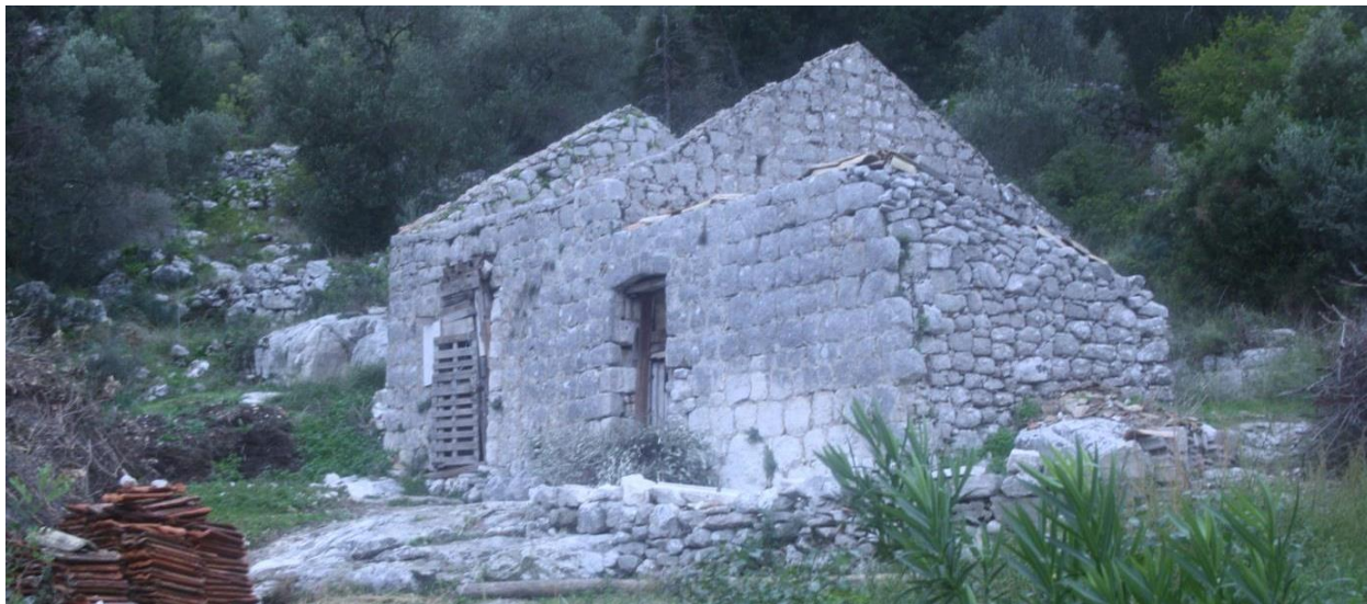
Gradnja u suho (muro de petra)
