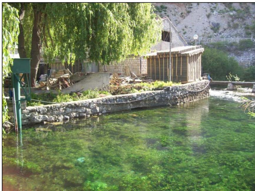
Izvor se koristi kao glavni zahvat za Vodoopskrbne sustave Župa dubrovačka i Konavle, kojima se opskrbljuju istoimena područja. Voda se zahvaća u blizini strojarnice hidroelektrane Dubrovnik. Instalirani kapacitet na zahvatu je  $230 \text{ l/s}$ , od čega  $115 \text{ l/s}$  za potrebe Župe dubrovačke i  $115 \text{ l/s}$  za potrebe Konavala, a voda se zahvaća na koti  $1,0 \text{ m n.m.}$
