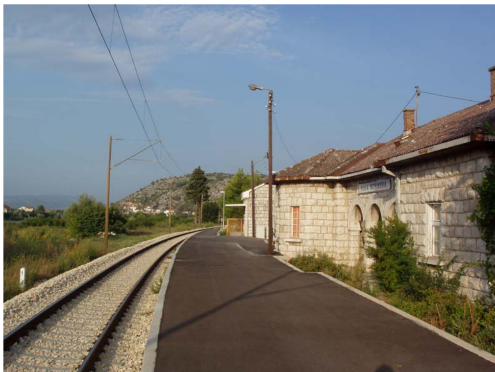
Željezničko stajalište Kula Norinska
