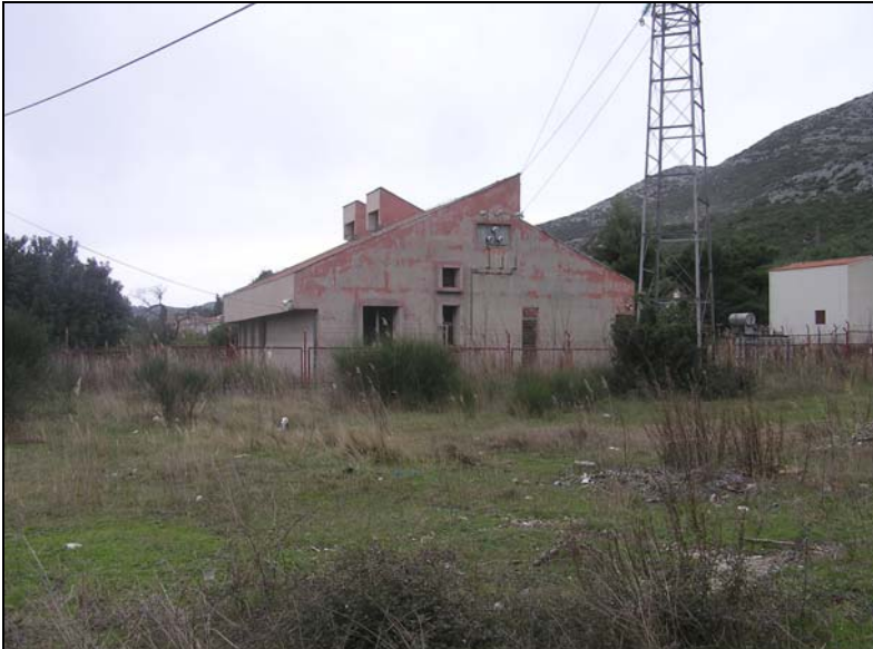
Slika 6.: Trafostanica u obuhvatu Plana
