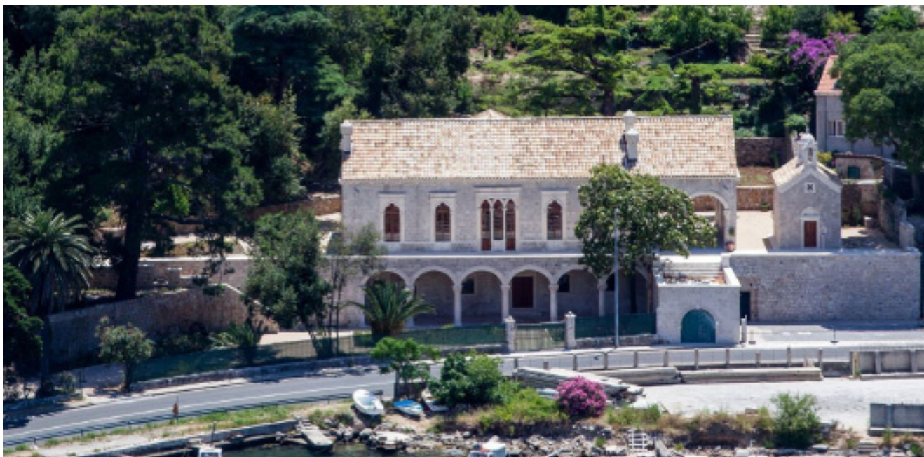
Slika 40: Ljetnikovac Bunić-Kaboga nakon obnove © Dubrovnik Neretva County
