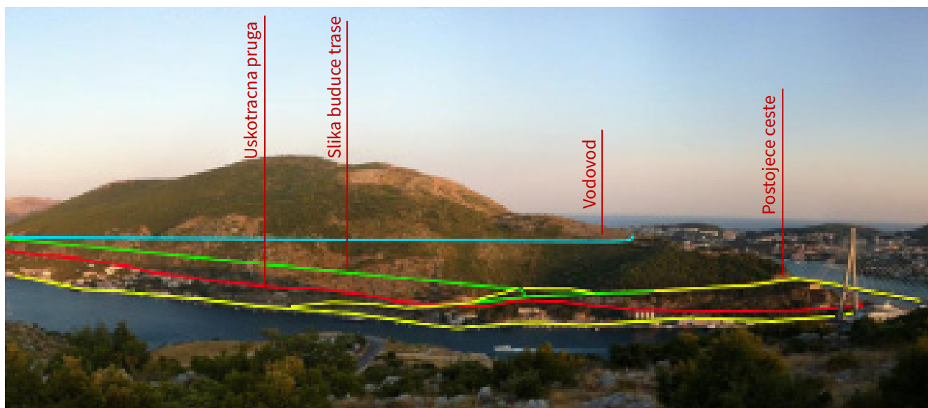
Slika 37: Most Dr. F. Tuđmana na južnoj strani Rijeke dubrovačke. Uskotracna Pruga (crvena linija), postojeća cesta (žuta linija), planirana cesta (zelena linija) i vodovod (plava linija) označeni su na fotografiji © PROMET MILENIJUM d.o.o. Čarli Brezac Benigar, ing.prom.
