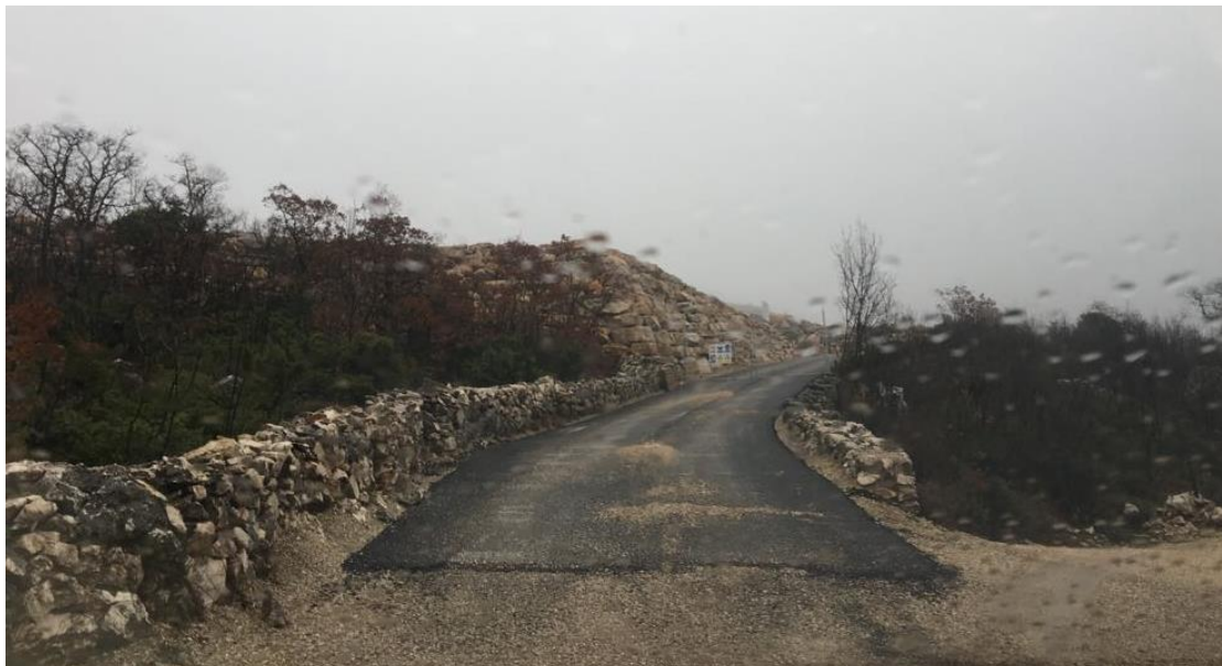
Slika 12. Pristupna prometnica do GO (zone za gospodarenje građevinskim otpadom)
