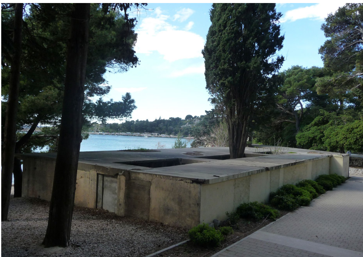
Kupališna zgrada u Srebrenome 2010. godine
