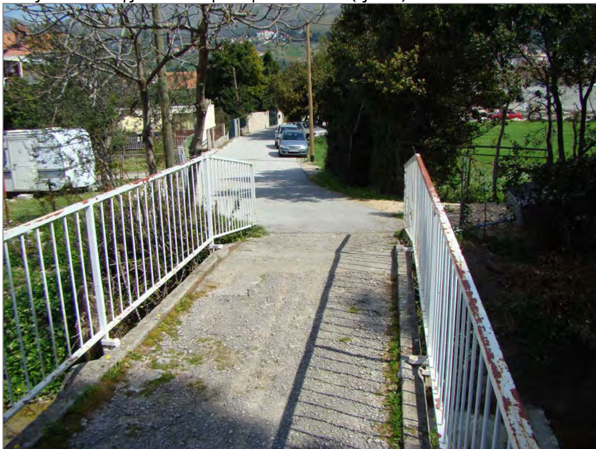
Postojeći "kolno" - pješački most preko potoka Taranta (Rječina)
