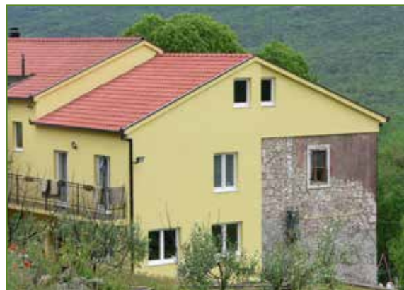
Loš primjer nadogradnje stare kuće
