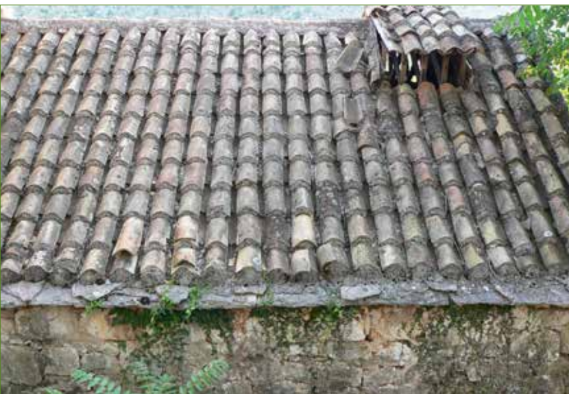
Krovni pokrov kupom kanalicom u Vidonjama
