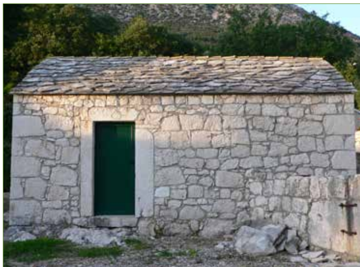
Krovni pokrov kamenim pločama u Desnama
