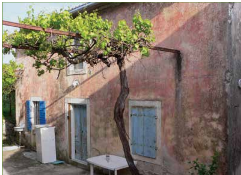
Ožbukano pročelje u zaseoku Rudine-Katići
