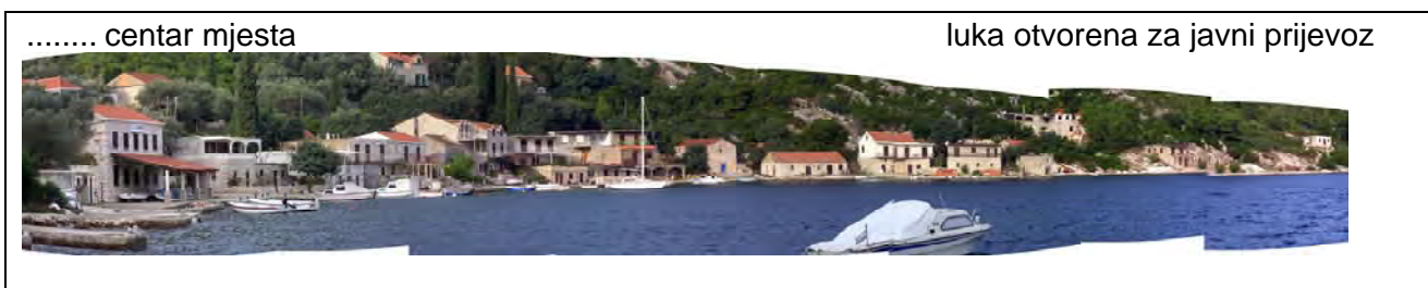
Slika 3-4: Obalno pročelje Prožurske Luke, koje određuje i kopnenu granicu obalne šetnice. Nužna je sanacija i oblikovno međusobno usklađivanje izgradnje. Nasipavanje i proširenje obale radi formiranja obalne šetnice i puta za prolaz interventnog vozila.
