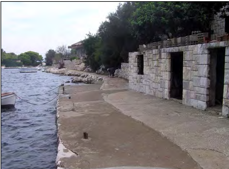
Slika 1-5-9 Izgled „rive“ koja se Planom planira proširiti za šetnicu i mogućnost provoza interventnog vozila.
