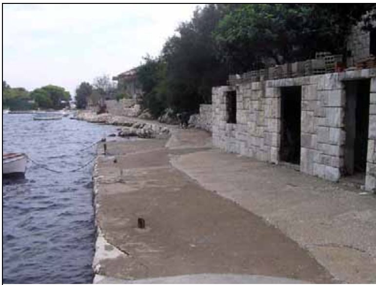
Slika 1-5-9 Izgled „rive“ koja se Planom planira proširiti za šetnicu i mogućnost provoza interventnog vozila.
