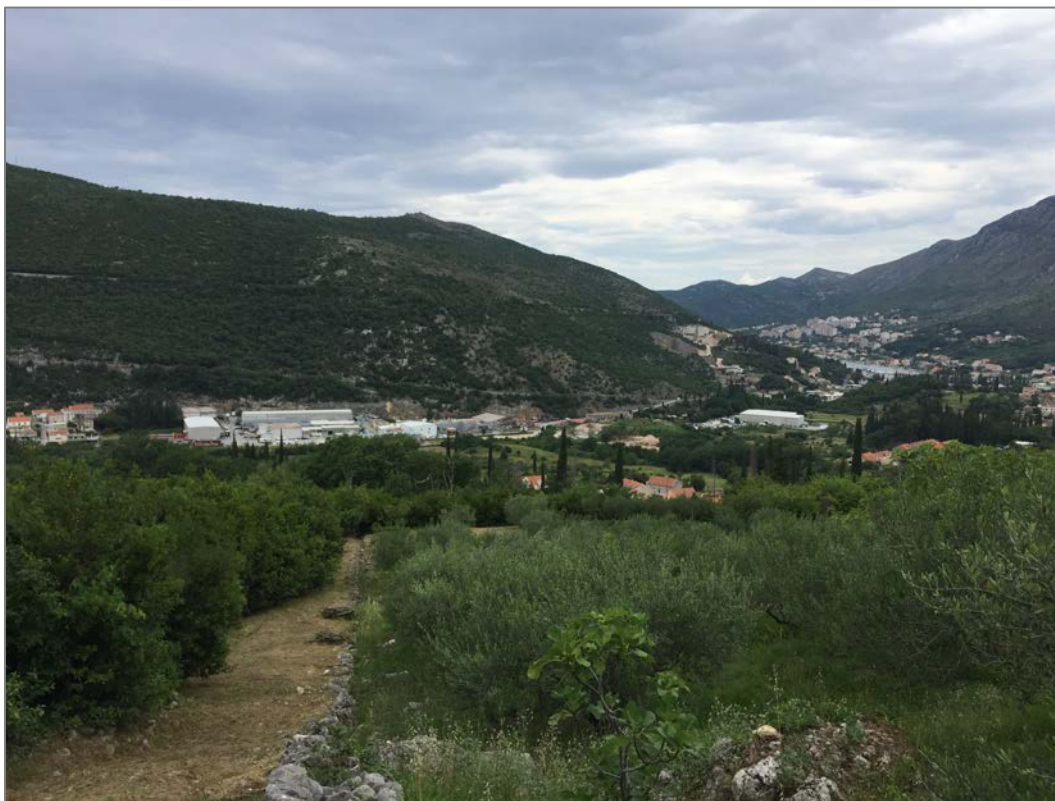
Grafički prikaz 04. Položaj proizvodnih i poslovnih objekata unutar udoline Šumet, podno sjevernih padina Srđa, u smjeru sjeverozapad-jugoistok Izvor: Urbanizam Dubrovnik d.o.o.
