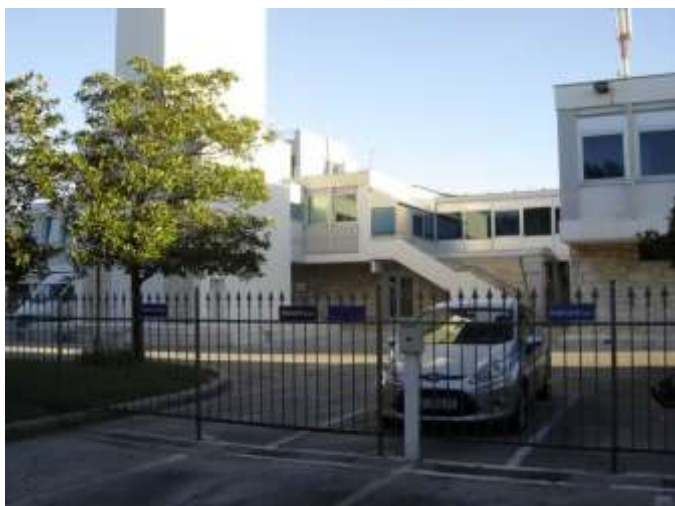
Upravna zgrada (oznaka 5) - landside
