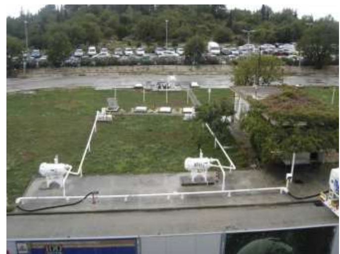
Ograđena zona spremište aviororiva (oznaka 13,14 i 15)
