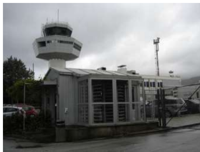
Kontrolna kućica – službeni prolaz u zonu airside (oznaka 20)
