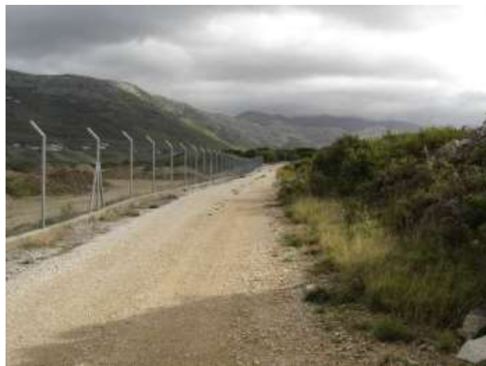
Prometnica sjeverno od USS i zaštitna ograda
