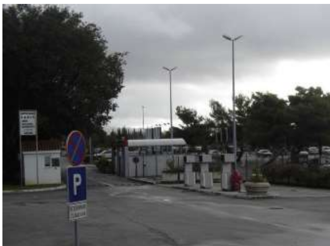
Interna crpna stanica za gorivo (oznaka 17)
