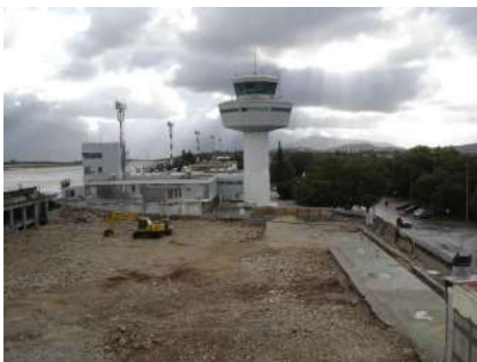
Gradilište zgrade C (oznaka 3) – landside
