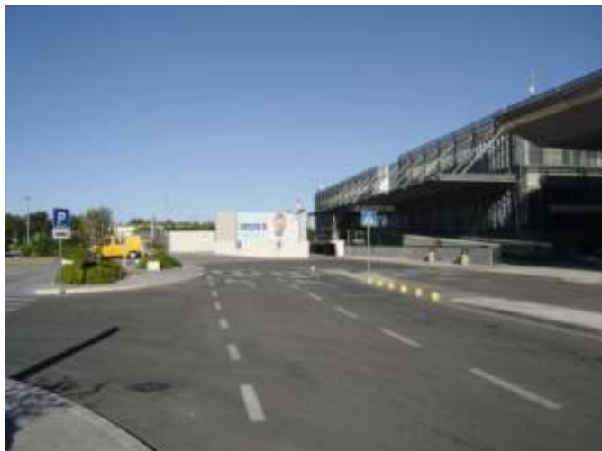
Prometnica uz zgrade A i B
