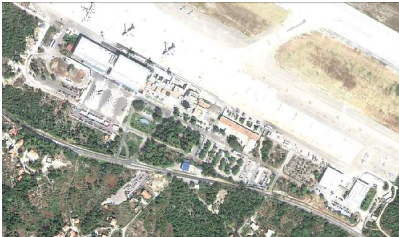
Prilog 19: Postojeća građevine Zračne luke Dubrovnik (Izvor: Google earth)
