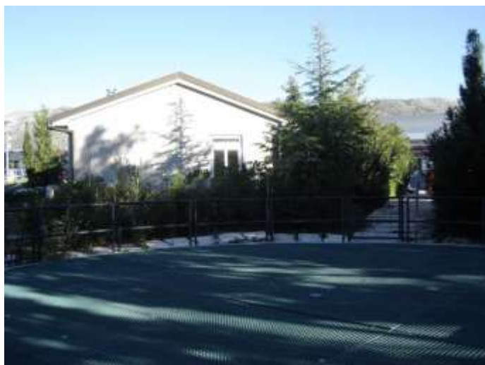
Strojarnica biopročištača (oznaka 11)
