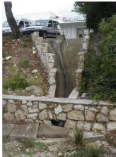
Odvodnja s cargo parkirališta
