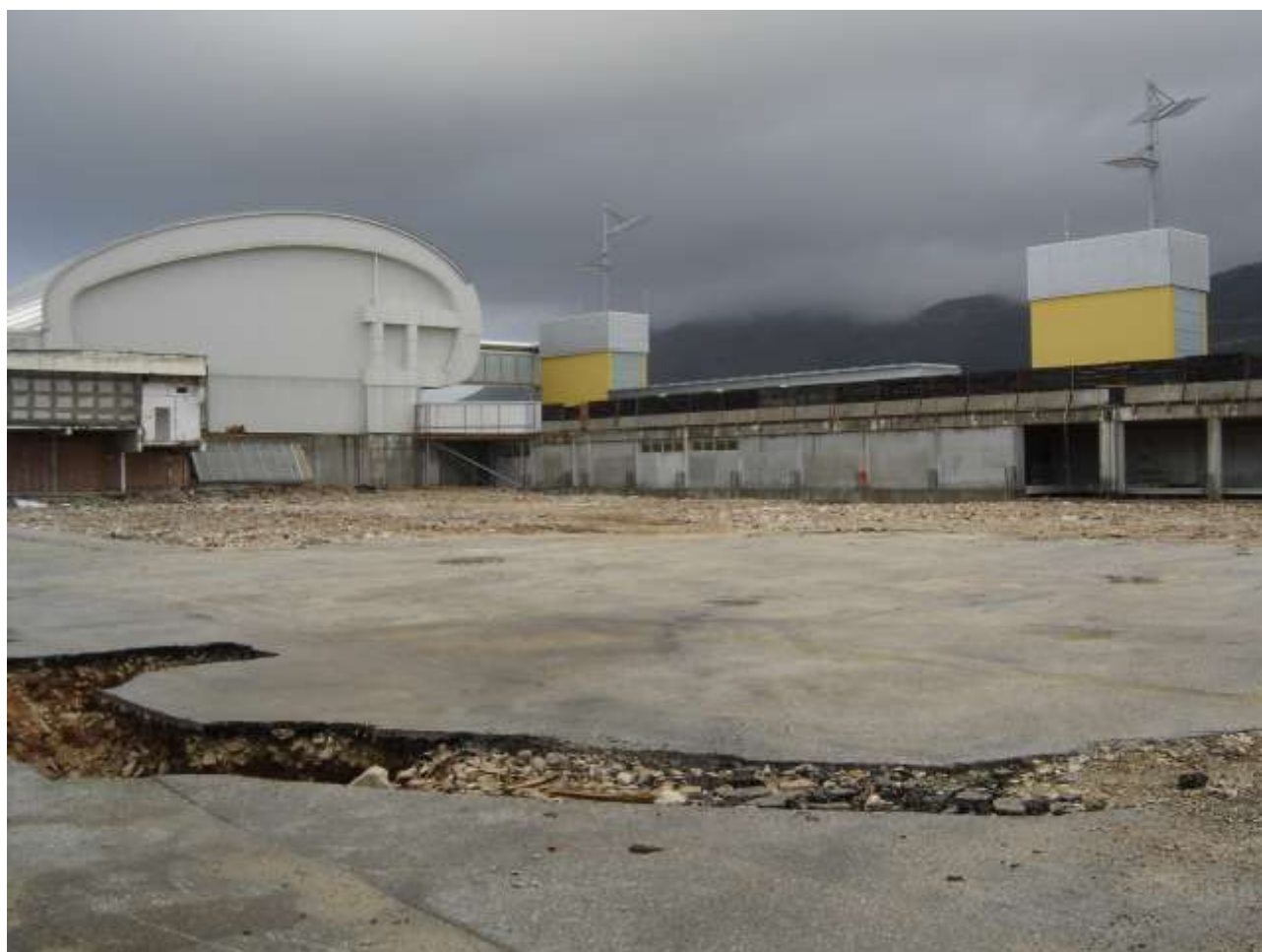
Prilog 26: Gradilište zgrade „C“ - I. faze radova (pripremni i zemljani radovi) (Izvor: Trames d.o.o, listopad 2012.)
