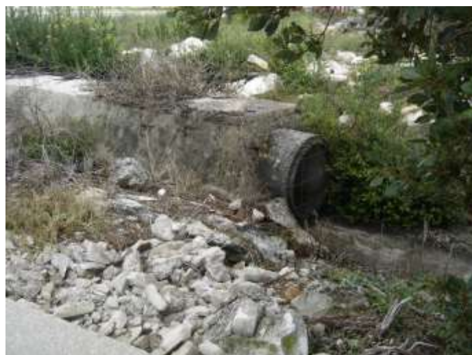
Prilog 95: Cjevovod oborinske kanalizacije na istočnom kraju stajanke opće avijacije - ispuštanje u okolni teren bez prethodne separacije masti i ulja. (izvor: Trames d.o.o., listopad 2012.)
