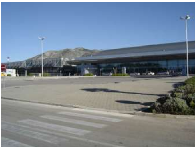
Zgrada A (oznaka 1) i B (oznaka 2) - landside
