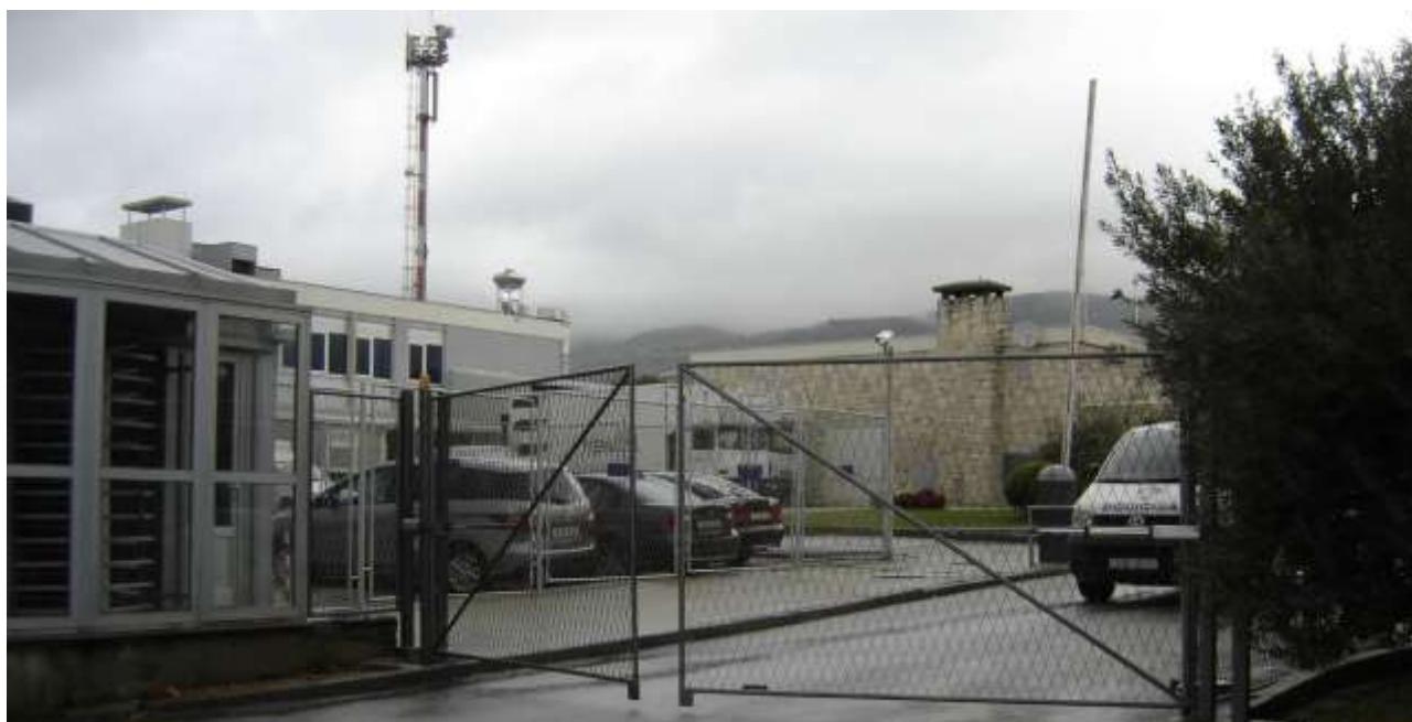
Prilog 31: Fotografija postojeće trafostanice (Izvor: Trames d.o.o, listopad 2012.)
